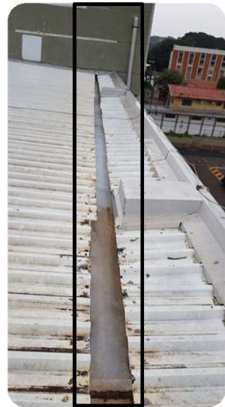
FOTOS 7 a 9: DETALHE DAS CALHAS SUBSTITUÍDAS DO PRÉDIO DO LEG.
