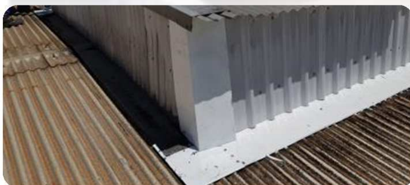
FOTO 2: DETALHE DO LANTERNIM EXECUTADO NA PLANTA PILOTO DO DEA.
