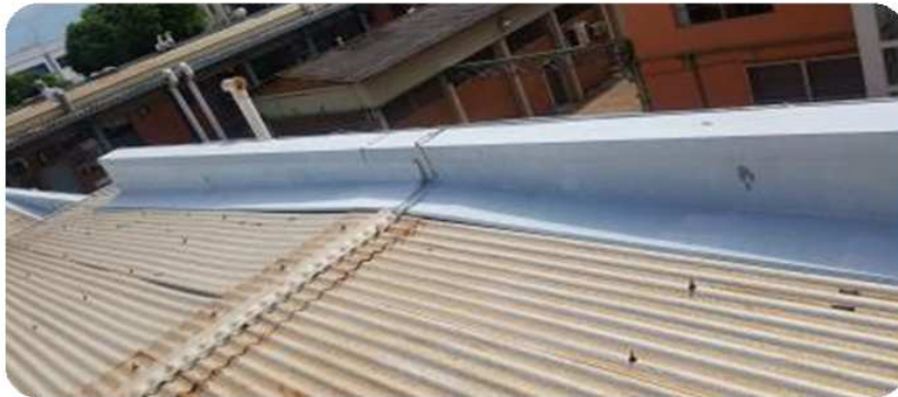
FOTO 4: DETALHE DOS RUFOS SUBSTITUÍDOS NO TELHADO DO DEPAN
