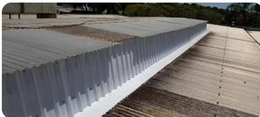
FOTO 1: DETALHE DO LANTERNIM EXECUTADO NA PLANTA PILOTO DO DEA.
