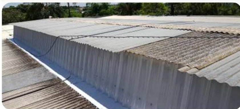
FOTO 3: DETALHE DO LANTERNIM EXECUTADO NA PLANTA PILOTO DO DEA.
