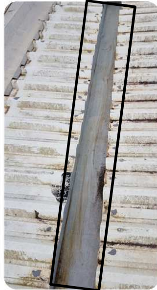
FOTOS 7 a 9: DETALHE DAS CALHAS SUBSTITUÍDAS DO PRÉDIO DO LEG.
