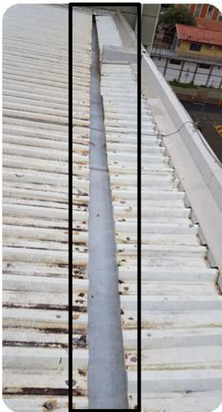
FOTOS 7 a 9: DETALHE DAS CALHAS SUBSTITUÍDAS DO PRÉDIO DO LEG.
