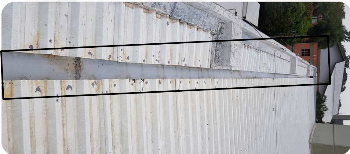
FOTO 10: DETALHE DAS CALHAS SUBSTITUÍDAS DO PRÉDIO DO LEG.
