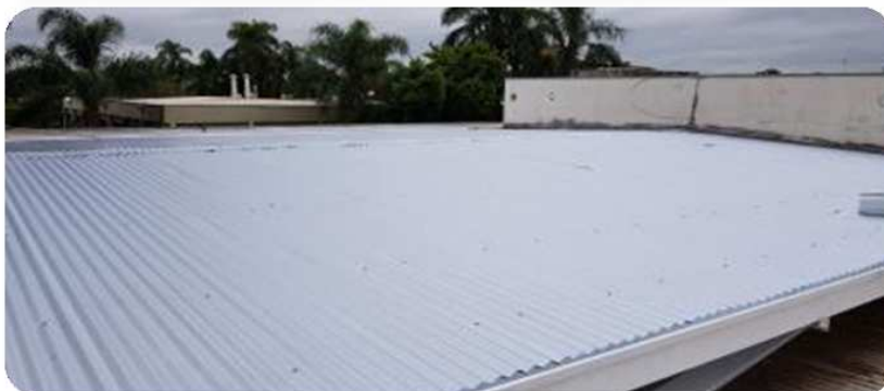
FOTO 6: DETALHE DO TRECHO DO TELHADO SUBSTITUÍDO.
