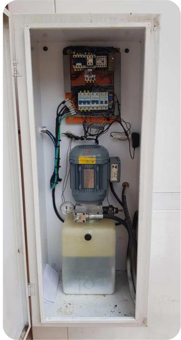
FOTO 1 E 2: Detalhe da plataforma do DTA e do sistema hidráulico que foi reparado.
