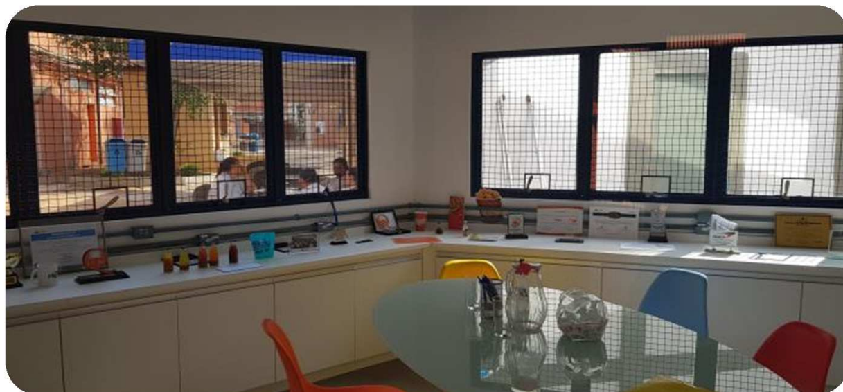
FOTO 3: FOTO DETALHE DA INFRAESTRUTURA ELÉTRICA E DE DADOS DA SALA DE REUNIÕES DO GEPEA.
