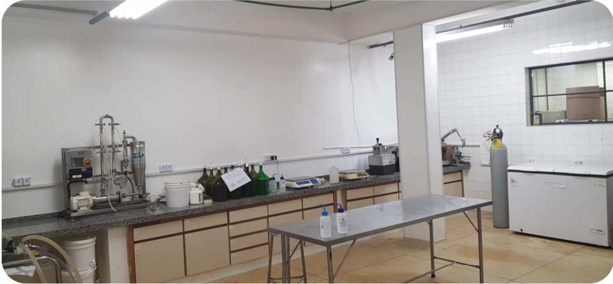
FOTO 1: FOTO DA PLANTA DE FRUTAS DO DTA. REMOVIDO AZULEJO, FEITO NOVO REVESTIMENTO E EXECUTADO BANCADA DE GRANITO.
