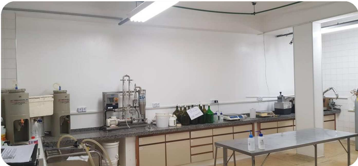
FOTO 2: FOTO DA PLANTA DE FRUTAS DO DTA. REMOVIDO AZULEJO, FEITO NOVO REVESTIMENTO E EXECUTADO BANCADA DE GRANITO.
