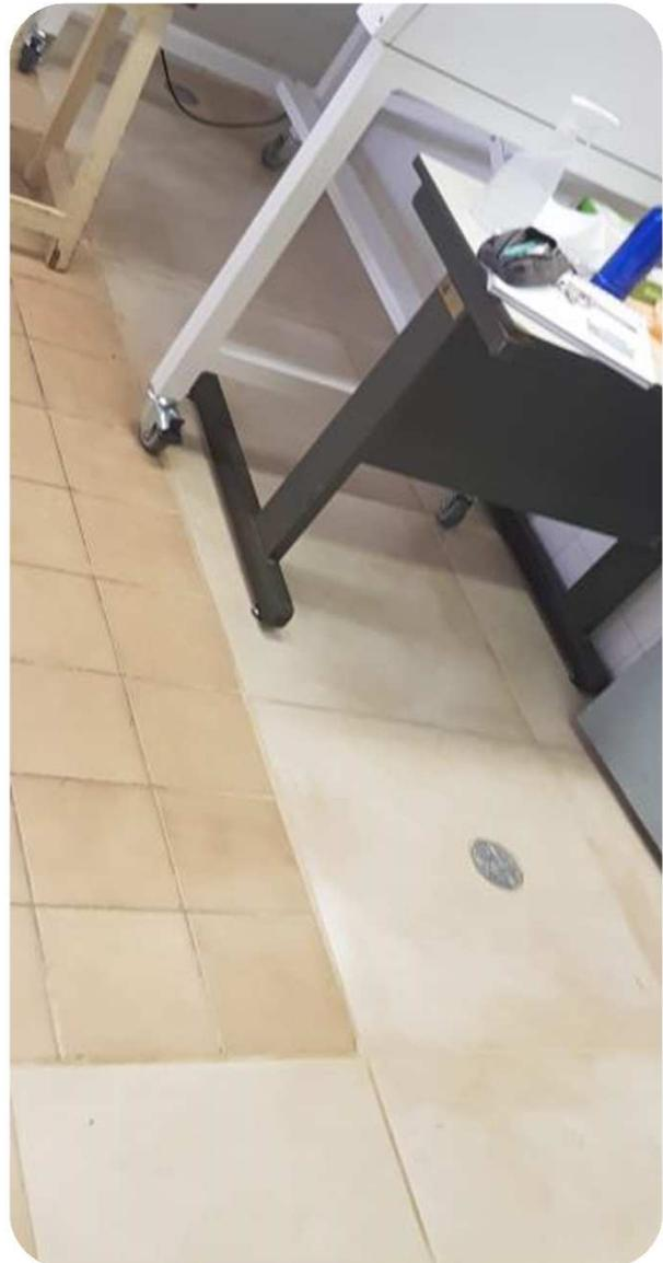
**FOTO 1 E 2:** FOTO DO SERVIÇO JÁ FINALIZADO. AS CANALETAS FORAM FECHADAS E CONCRETADAS. FOI INSTALADO RALOS SIFONADOS EM DIVERSOS PONTOS DOS LABORATÓRIOS.
