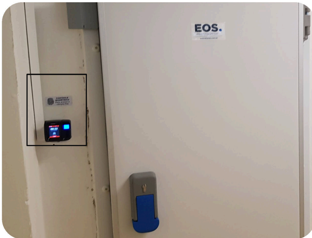
FOTO 1: Controle de acesso por biometria. Somente pessoas cadastradas conseguem acessar as câmaras de congelamento e resfriamento.
