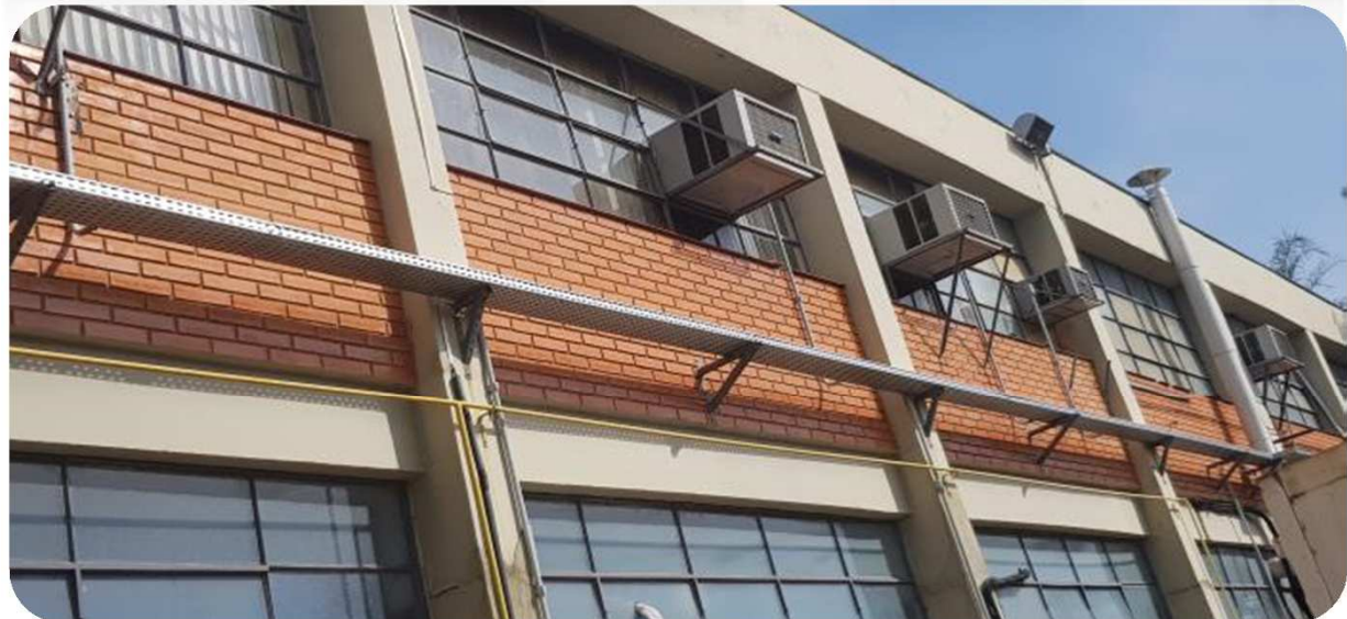
FOTO 1: CALHAS ELÉTRICAS 200 X 50 MM INSTALADAS NA PLANTA PILOTO DO DEA.
