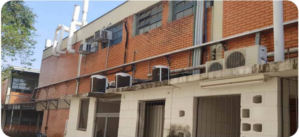
FOTO 1: CALHAS ELÉTRICAS 200 X 50 MM INSTALADAS NA PLANTA PILOTO DO DEA.
