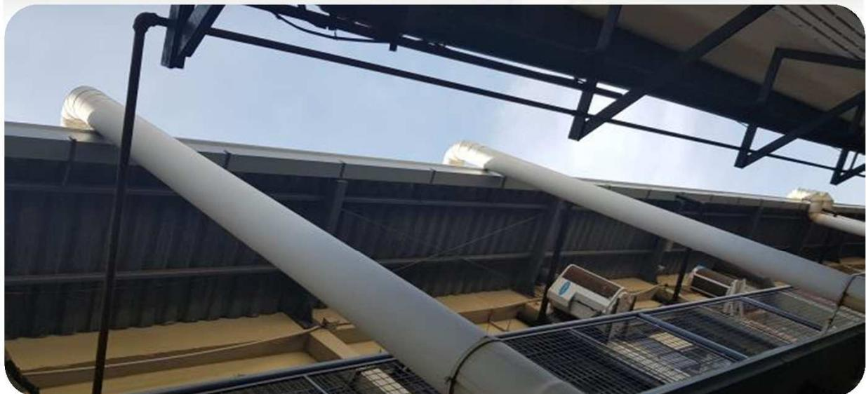
**FOTO 2:** DETALHE DAS CALHAS SUPERIORES INSTALADAS EM TODO O PERÍMETRO DO PRÉDIO DO DCA.
