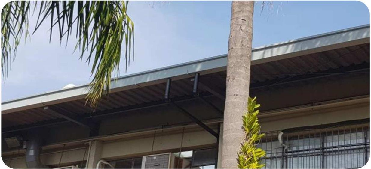
**FOTO 1:** DETALHE DAS CALHAS SUPERIORES INSTALADAS EM TODO O PERÍMETRO DO PRÉDIO DO DCA.
