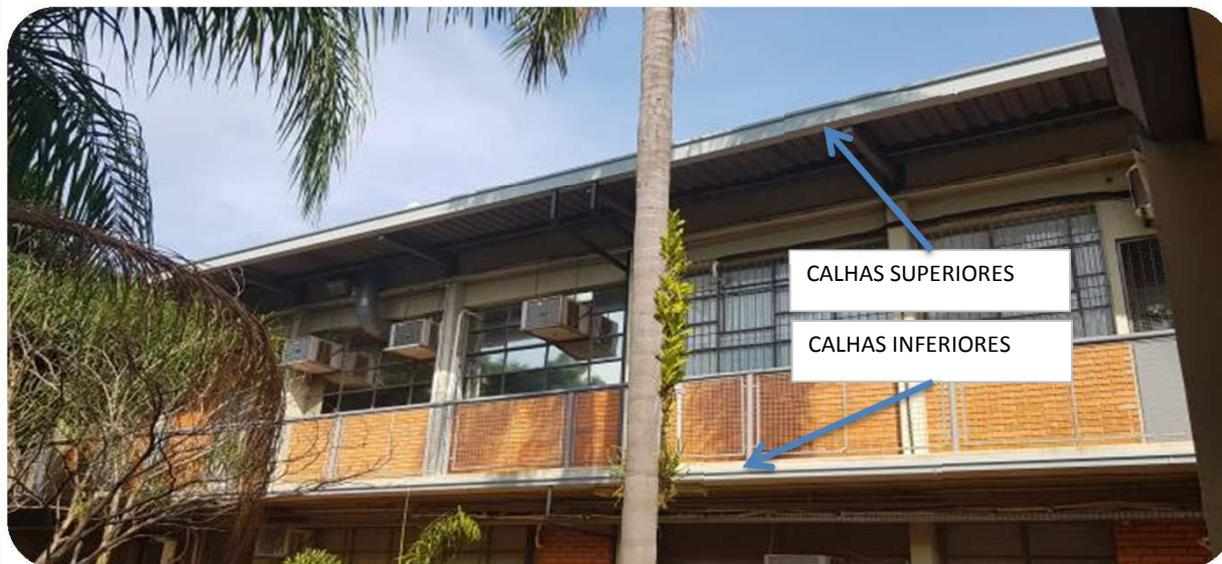
**FOTO 3:** DETALHE DAS CALHAS SUPERIORES (CALHAS DE COLETA DE ÁGUA DE CHUVA) E CALHAS INFERIORES (COLETA DE ÁGUA DE LAVAGEM DE LABORATÓRIO E DE DRENOS DE AR CONDICIONADO).
