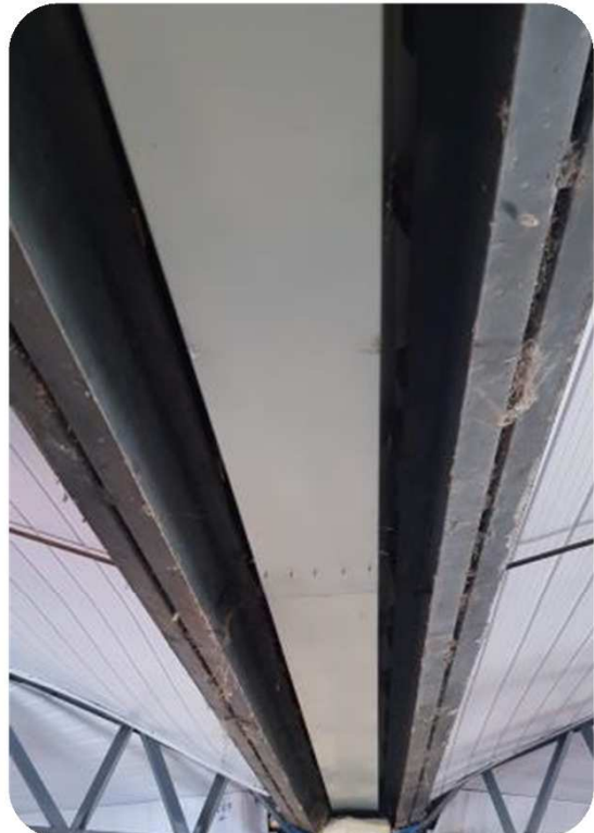
FOTO 1 E 2: Detalhe da substituição da calha central do prédio da CAFEA.
