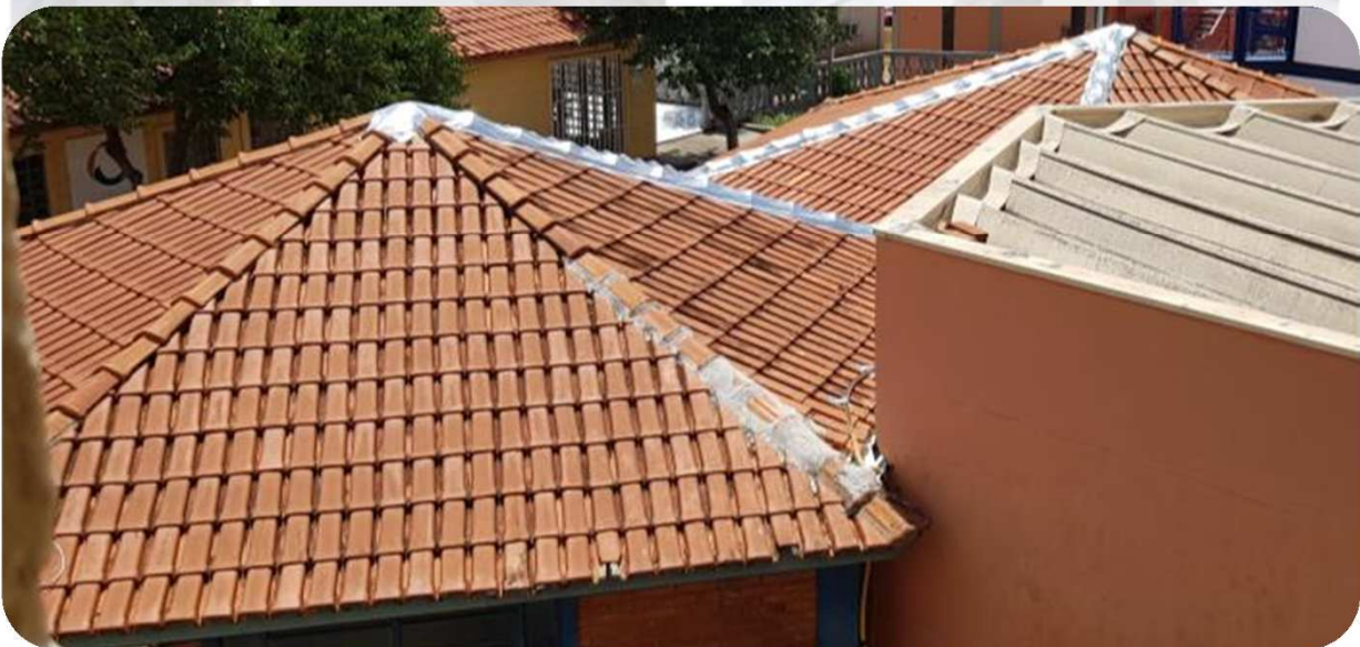
FOTO 3: Detalhe da instalação de manta asfáltica nas cumieiras do prédio do CAFEA.
