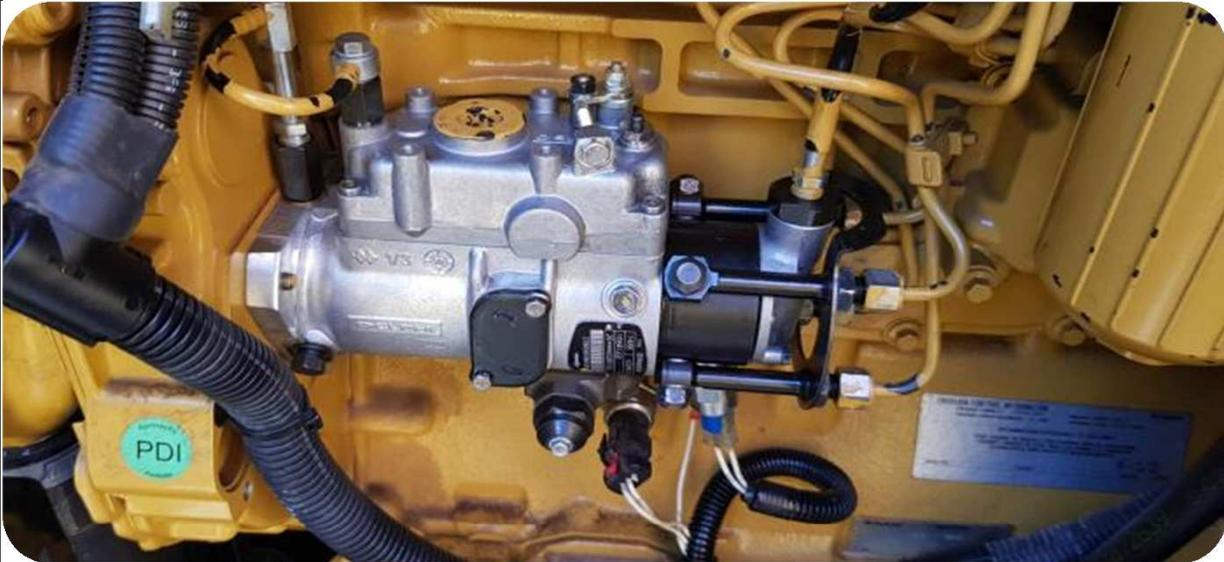
**FOTO 1:** FOTO DA BOMBA INJETORA DO GERADOR DE ENERGIA DO DEA APÓS A MANUTENÇÃO.
