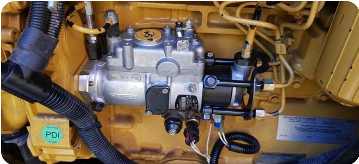
**FOTO 2:** FOTO DA BOMBA INJETORA DO GERADOR DE ENERGIA DO DTA APÓS A MANUTENÇÃO.
