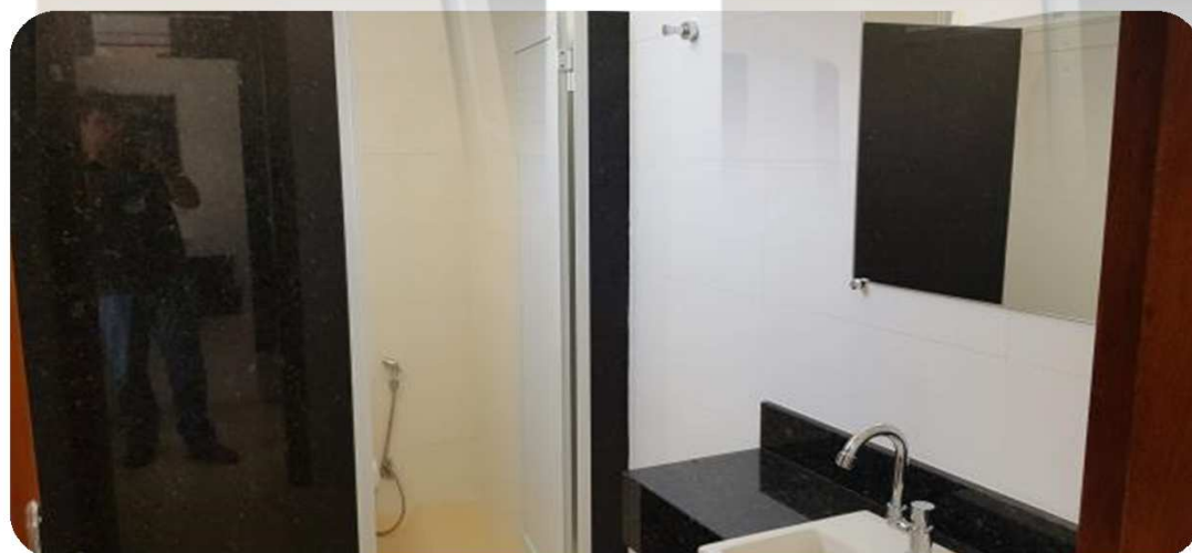
FOTO 6: Detalhe dos banheiros masculino e feminino do 1º Piso do prédio ADM/DEA.
