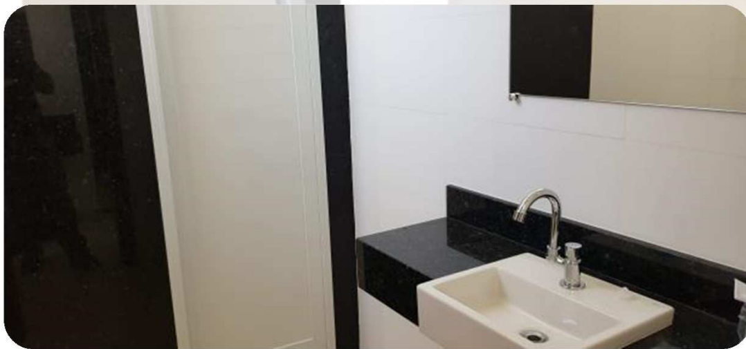
FOTO 3: Detalhe dos banheiros masculino e feminino do 1° Piso do prédio ADM/DEA.
