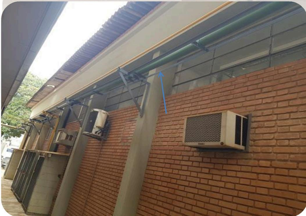
**FOTOS 01 e 02:** Em destaque nas imagens a estrutura metálica tipo "berço" executada para reforçar a infraestrutura de sustentação da audtora de água da FEA.
