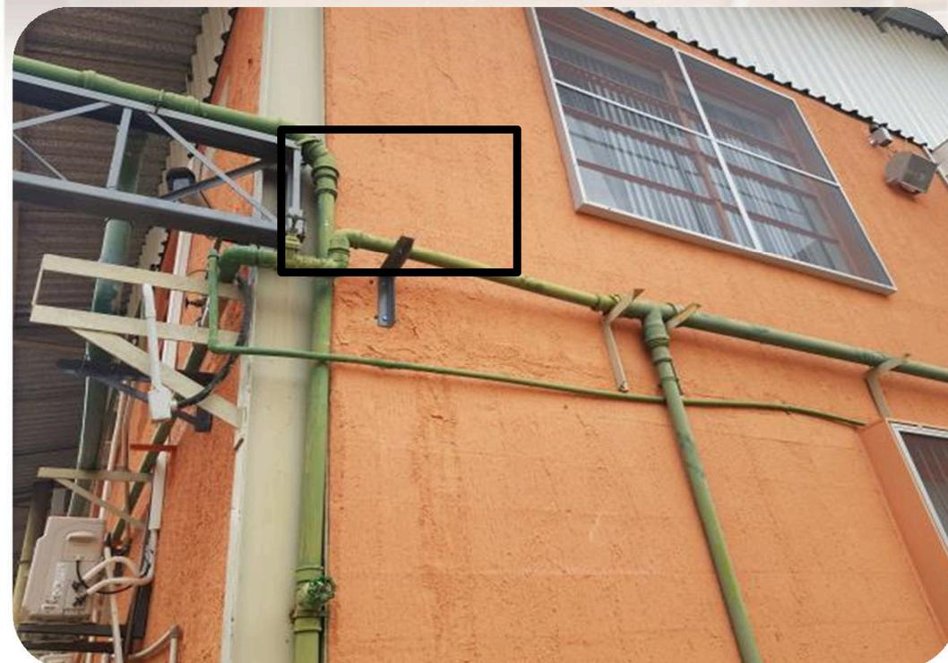
**FOTOS 05 e 06:** Em destaque nas fotos a estrutura metálica tipo "mão francesa" executada em toda a extensão da adutora da FEA para reforçar a infraestrutura de sustentação da adutora de água da FEA.
