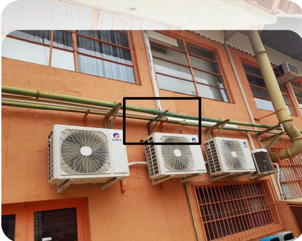
**FOTOS 03 e 04:** Em destaque nas fotos a estrutura metálica tipo "mão francesa" executada em toda a extensão da adutora da FEA para reforço a infraestrutura de sustentação da adutora de água da FEA.
