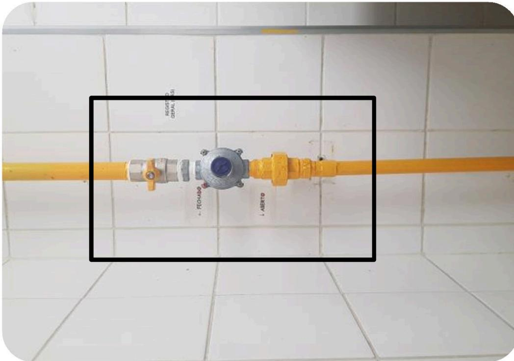
**FOTO 03:** Em destaque na imagem a válvula reguladora de pressão. Foram instaladas em todos os laboratórios para garantir a segurança das operações que utilizam Gás Natural.
