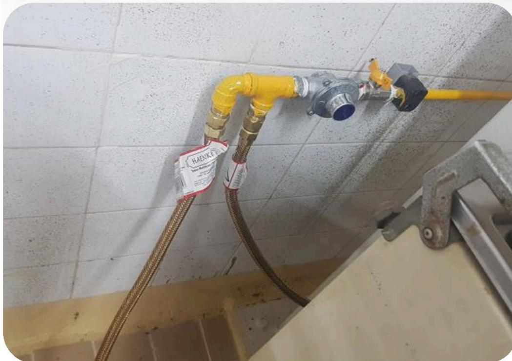
**FOTO 04:** Em destaque na imagem a válvula reguladora de pressão e as mangueiras metálicas tramadas, padrão NBR. Em todos os pontos fixos de consumo de Gás Natural (fogões e fornos), em atenção as normas técnicas vigentes, foram instaladas as referidas mangueiras - que possuem validade de 05 anos.
