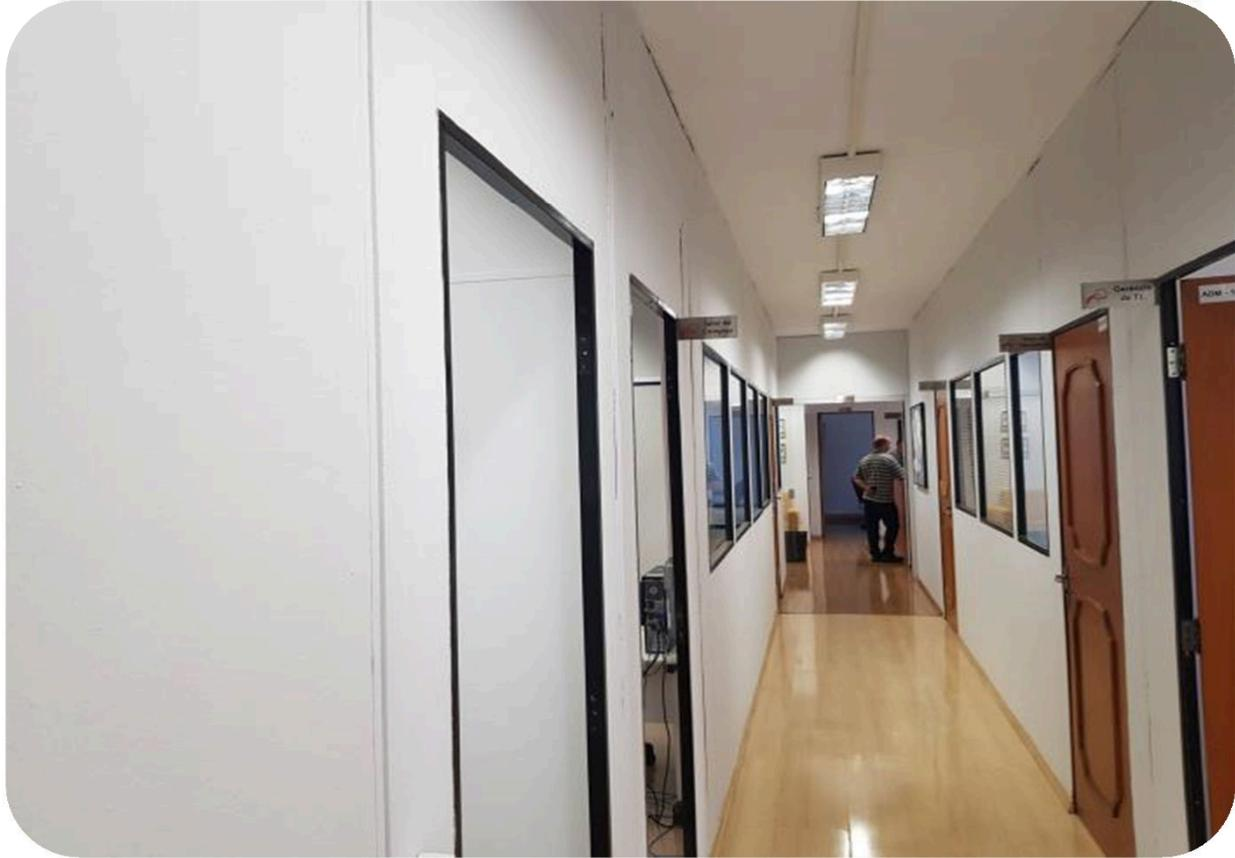
**FOTO 03:** Em destaque na imagem a pintura executada no corredor do primeiro piso do prédio da Diretoria. Foi optado pela cor branco gelo.
