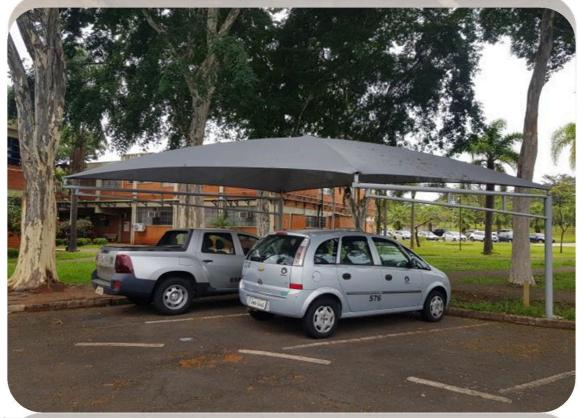
**FOTOS 01 e 02:** Em destaque na foto a cobertura, tipo sombreiro, executado no estacionamento da FEA para possibilitar a guarda dos veículos oficiais da faculdade.
