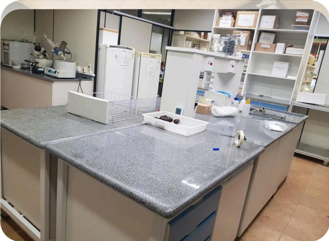
**FOTOS 1 e 2:** Em destaque nas fotos a bancada central que foi construída no LAPEA/DETA/FEA. A bancada foi executada com madeira estruturada (MDF de alta qualidade) com pedra de granito. Também foi executado toda a infraestrutura elétrica e hidráulica, para atender a demanda pedagógica atual.
