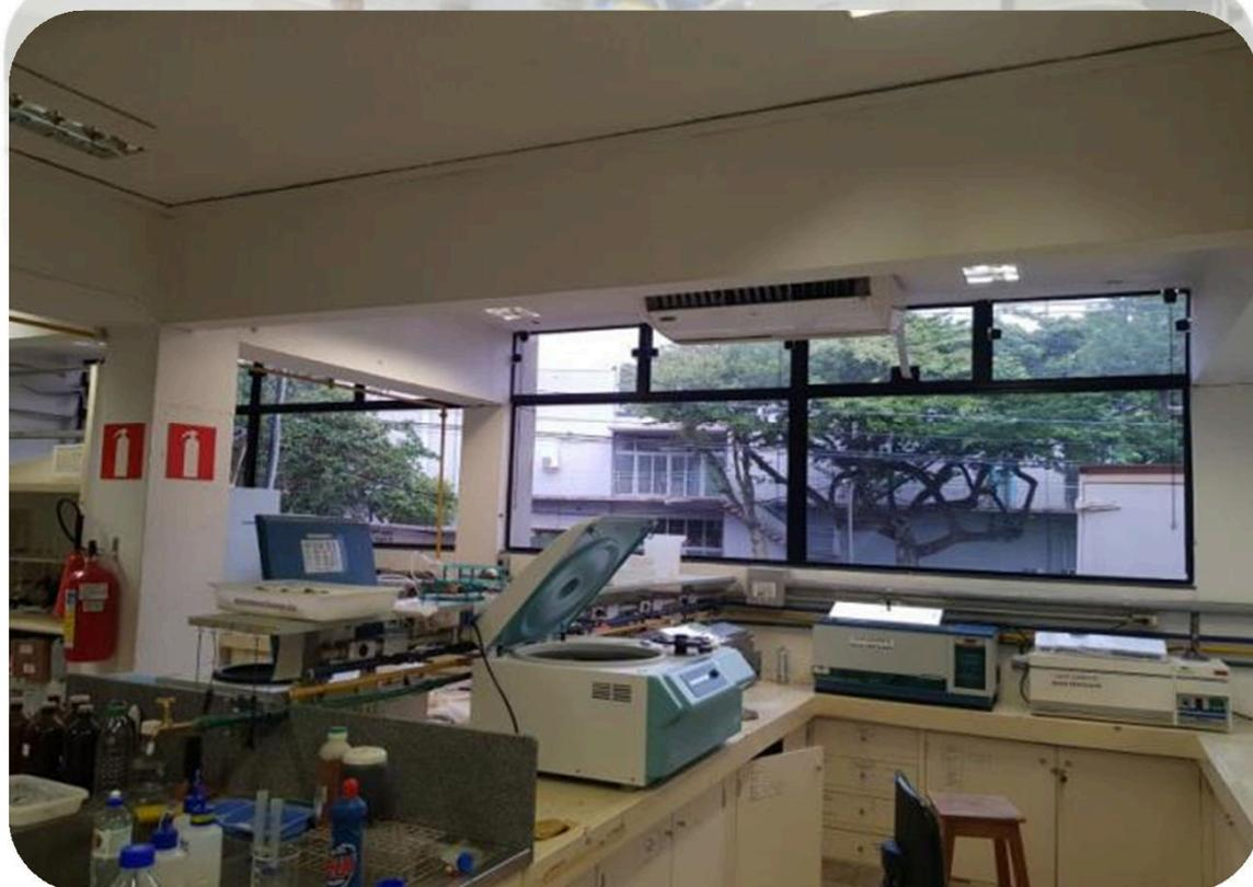
**FOTOS 1 e 2:** Substituição de todos os caixilhos existentes do LEMEB/DETA/FEA. Foi removido caixilho metálico existente e no local foi instalado caixilho em alumínio com vidro temperado com película anti-vandalismo e com controle solar.
