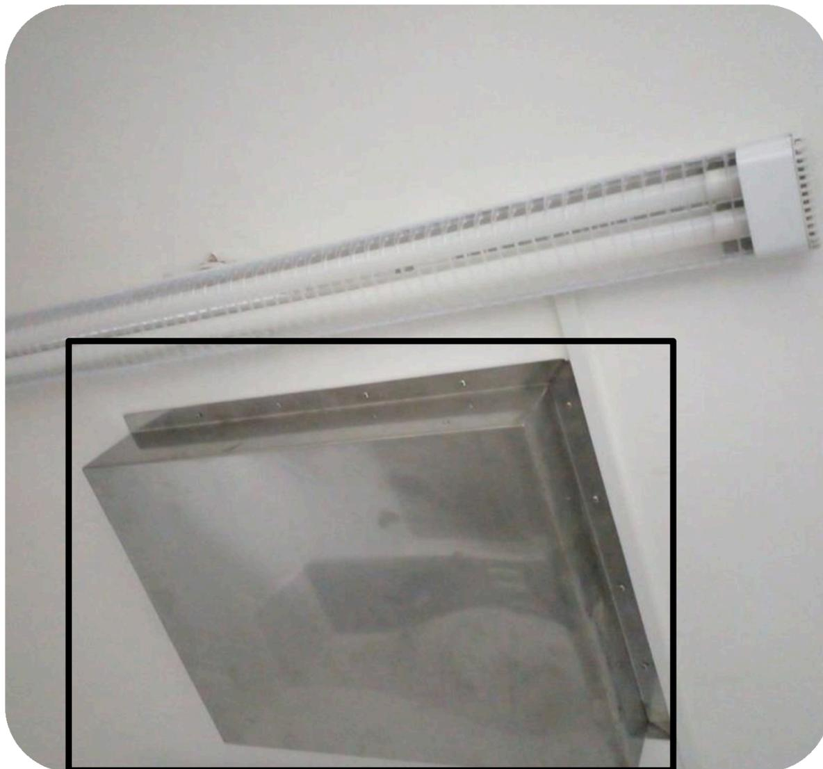
**FOTO 2:** Em destaque o suporte de inox que foi instalado no forro da cirurgia do Laboratório de Ensaios Biológicos/DECAN/FEA, para alterar o fluxo de ar do ambiente.
