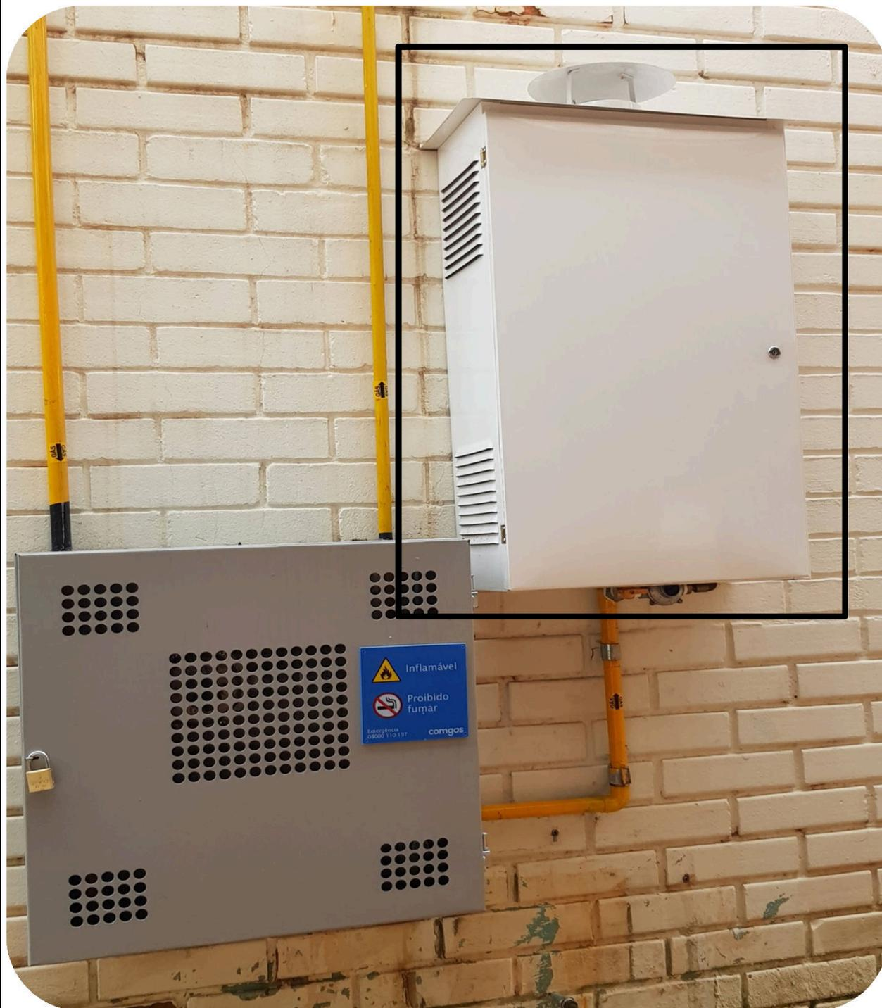
**FOTO 1:** Em destaque na imagem o aquecedor de água que foi instalado do lado externo do prédio do Laboratório de Ensaios Biológicos/DECAN/FEA. Para evitar utilização indevida, foi instado abrigo metálico.
