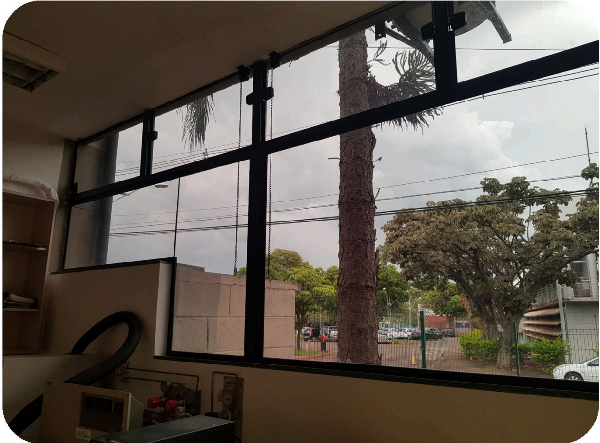
FOTO 3: Substituição do caixilho existente na salinha de equipamentos do LEP/DETA/FEA (DEA-08). Foi removido caixilho metálico existente e no local foi instalado caixilho em alumínio com vidro temperado com película anti-vandalismo e com controle solar.
