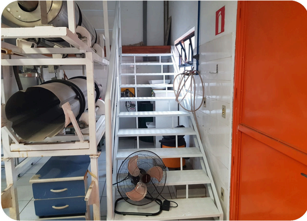
FOTO 1: Detalhe da escada metálica executada entre o piso térreo e o mezanino do Laboratório de Extrusão - DTA/DETA/FEA. Estrutura montada de acordo com as normas vigentes.
