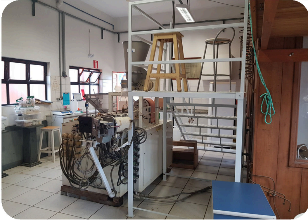
FOTO 3: Detalhe da escada metálica executada para possibilitar a alimentação, com segurança operacional, da extrusora do Laboratório de Extrusão - DTA/DETA/FEA. Estrutura montada de acordo com as normas vigentes.
