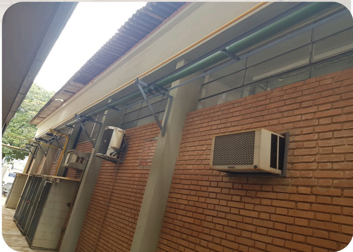
FOTOS 1 a 3: Em destaque nas fotos trechos da rede de distribuição que foram substituídos (redimensionados) para atender a vazão e pressão do Gás Natural.
