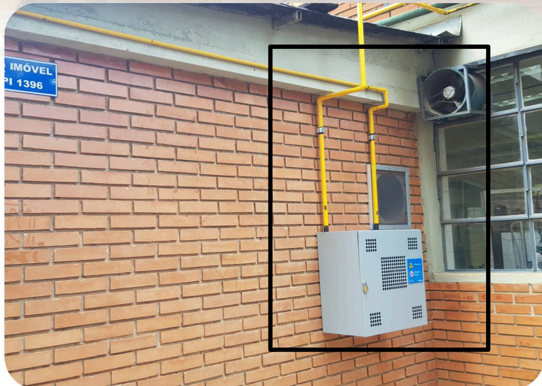
FOTOS 1 a 3: Em destaque nas fotos trechos da rede de distribuição que foram substituídos (redimensionados) para atender a vazão e pressão do Gás Natural.
