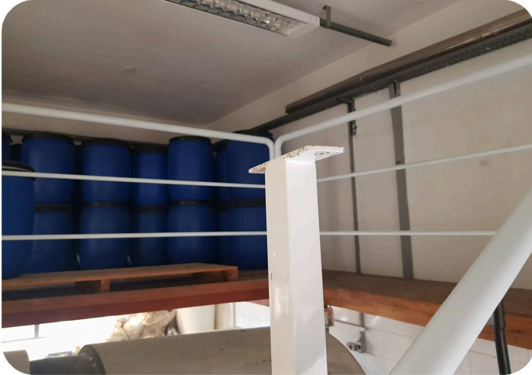
**FOTO 1:** Detalhe do guarda corpo metálico executado no mezanino do Laboratório de Extrusão - DTA/DETA/FEA. Altura: 1,10 metros, conforme legislação vigente.
