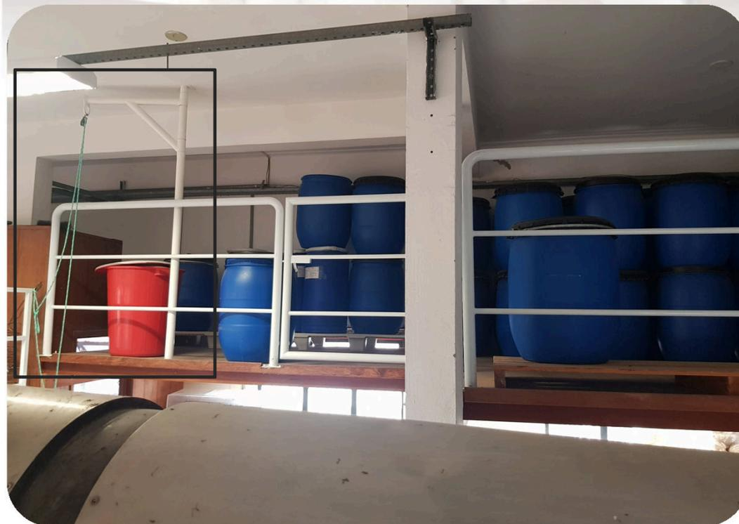
**FOTO 2:** Detalhe do guarda corpo metálico executado no mezanino do Laboratório de Extrusão - DTA/DETA/FEA. Também foi executado sistema para içamento de cargas, para atender a demanda pedagógica atual, ver destaque na imagem.
