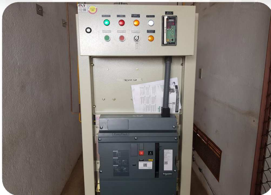
FOTOS 1 E 2: DETALHE DO ANTIGO DISJUNTOR - QUE TINHA MAIS DE 20 ANOS DE USO.
