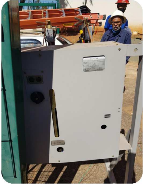
FOTOS 1 E 2: DETALHE DO ANTIGO DISJUNTOR - QUE TINHA MAIS DE 20 ANOS DE USO.
