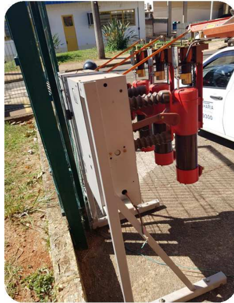
FOTOS 1 E 2: DETALHE DO ANTIGO DISJUNTOR - QUE TINHA MAIS DE 20 ANOS DE USO.
